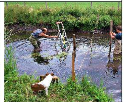
Jean-Jacques installe la pile qui supportera la passerelle au-dessus du ruisseau. 9 m de berge à berge
