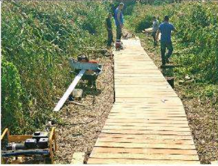
L'ESAT de Montsauche-les-Settons (toujours la proximité) vient installer le platelage pour garantir la pérennité du sentier.
